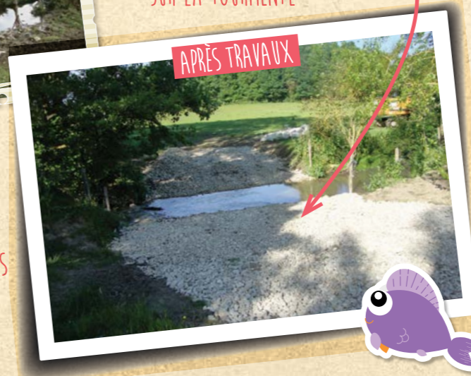
AMÉNAGEMENT D'UN PASSAGE À GÜÉ POUR LE BÉTAIL SUR LA TOURMENTE
